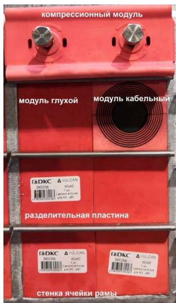
Рисунок 1 – Кабельная проходка на основе металлической рамы и модулей (одна ячейка)
